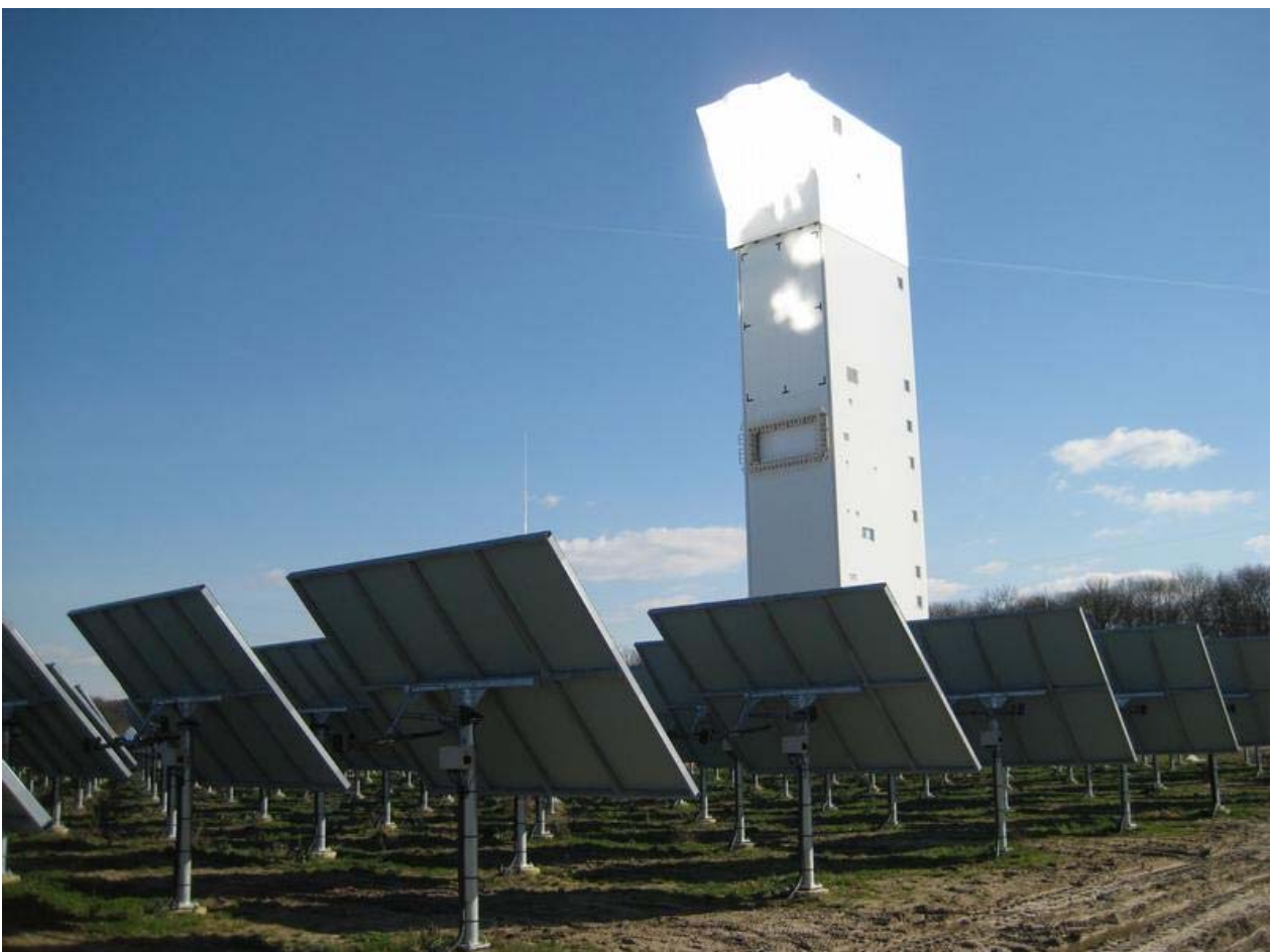
Abb. 3.54: Anordnung eines Solarturmkraftwerks
