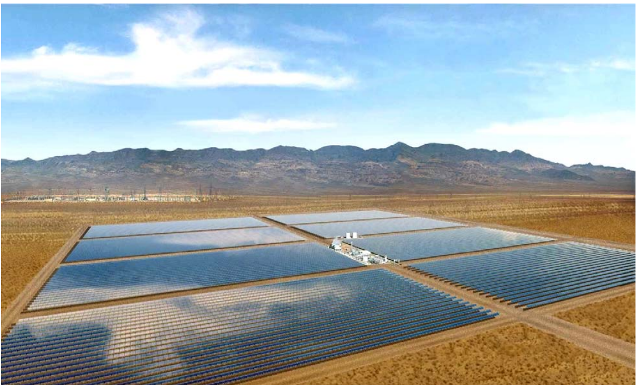
Abb. 3.53a: 64 Megawatt (MW) Parabolrinnenkraftwerk „Nevada Solar One“ im US-Bundesstaat Nevada
