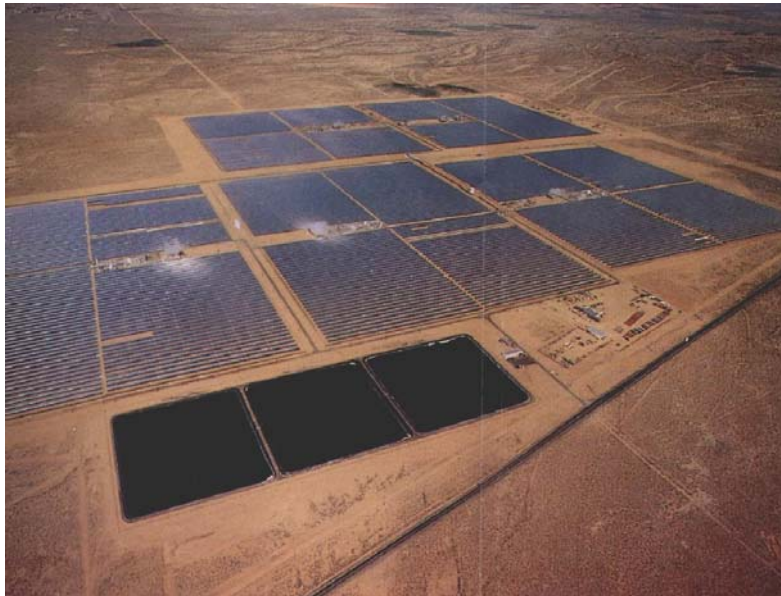
Abb. 3.53: Parabolrinnenkraftwerk in den USA /IZE/
