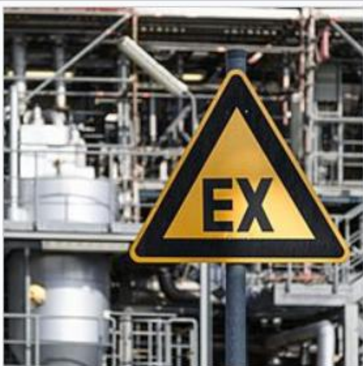
Markierung eines Bereiches mit Explosionsgefahren in einem Chemiewerk
